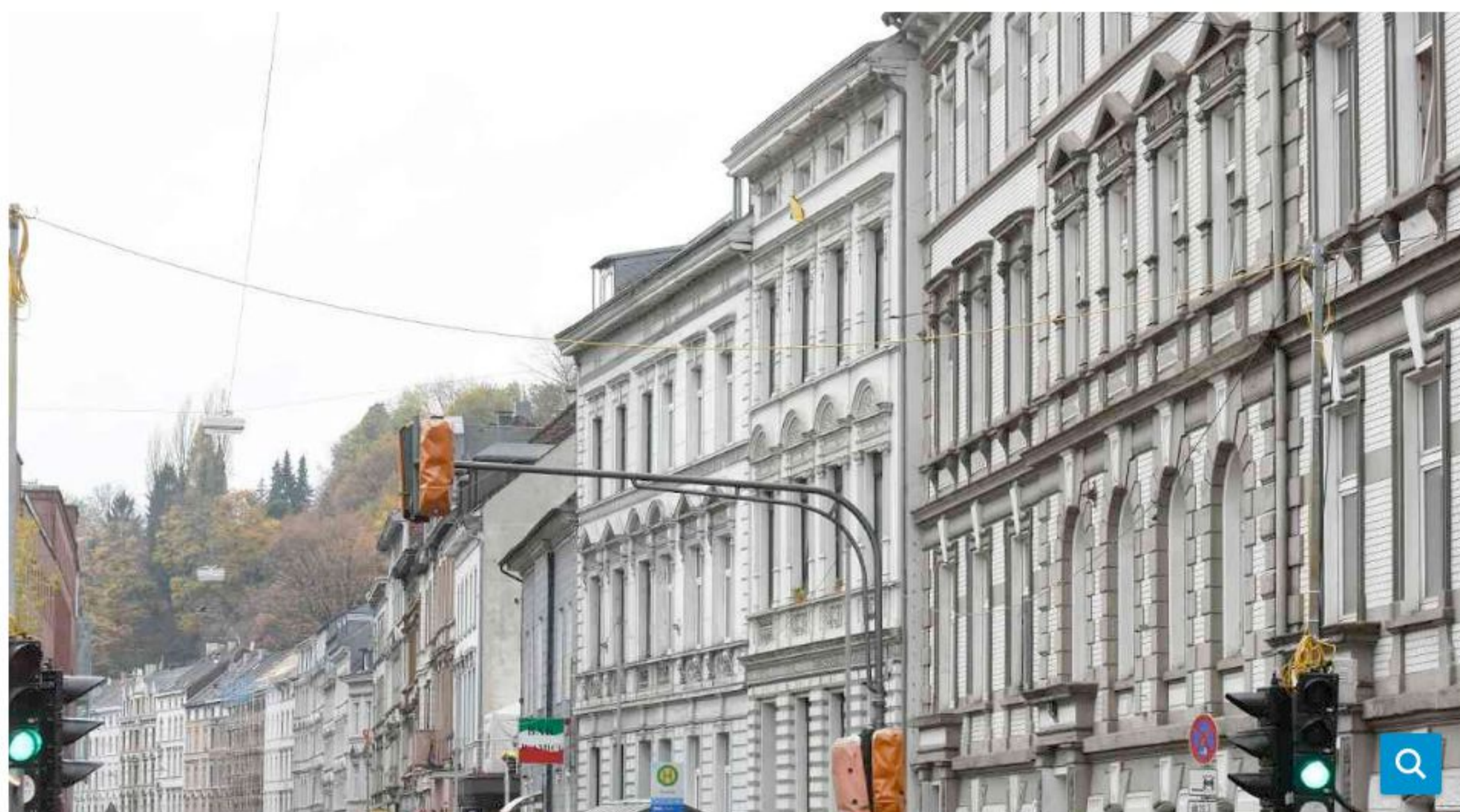
An der Friedrich-Ebert-Straße sollen im Winter einige Fassaden saniert werden. Foto: Fischer, Andreas (f22)
