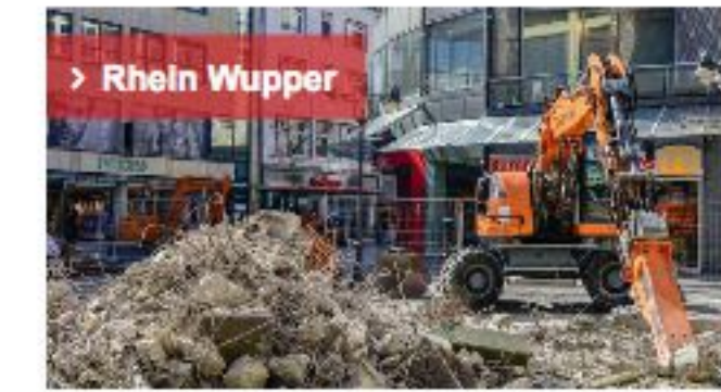
In Elberfeld rollen die ersten Bagger
