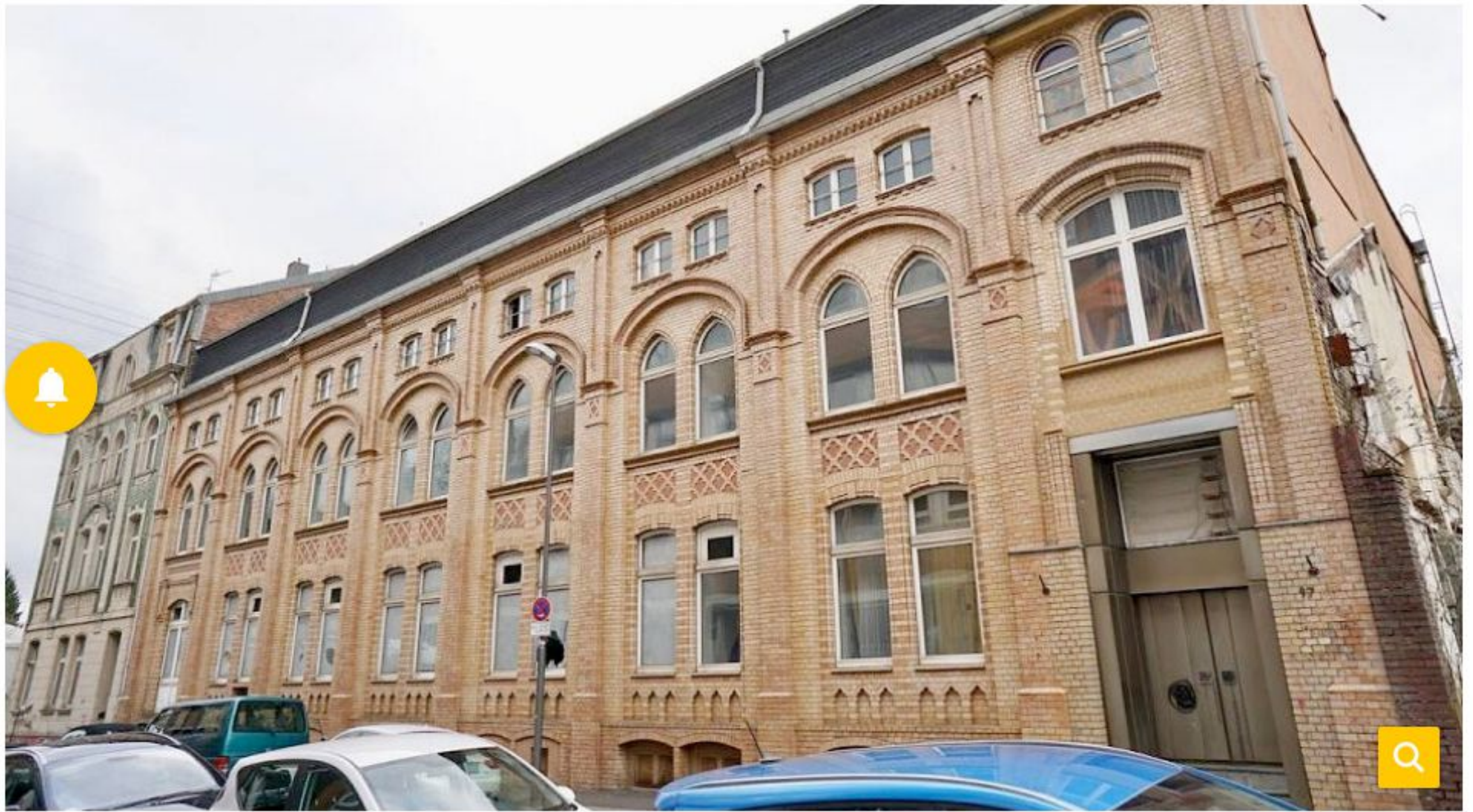
Typisch für das unter Denkmalschutz stehende Gebäude ist die Fassade mit ihren markanten Rundbogenfenstern. Foto: RAG
